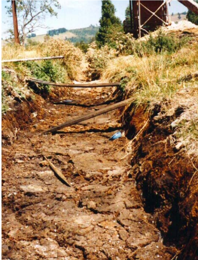
a) Residuales de un derrame químico en una canaleta de aguas lluvia
